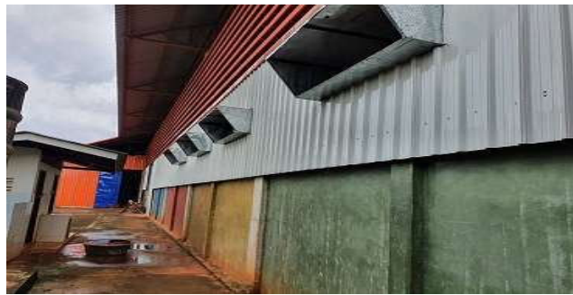
ภาพที่ 2 ช่องระบายความร้อนของห้องอบเมล็ดข้าวโพด
