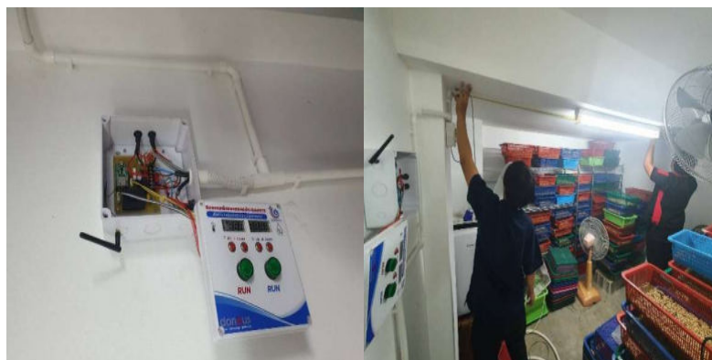
ภาพที่ 2 ระบบตรวจวัดอุณหภูมิและความชื้นแบบ Real time ภายในห้องอบเมล็ดกาแฟ
